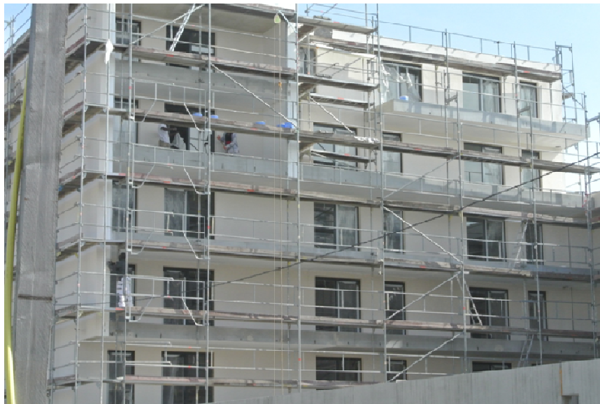
A gauche un bâtiment en construction. On distingue les plaques de polystyrène isolant.
